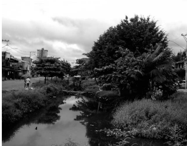
Figura 3 – Imagem de ocupação precária às margens de cursos d’água em Belém; “terrenos impróprios à habitação” (Belém, 2006b, p.17) são o objeto da invenção de uma desejável “orla fluvial” na cidade. Foto do autor, jan. 2007.
