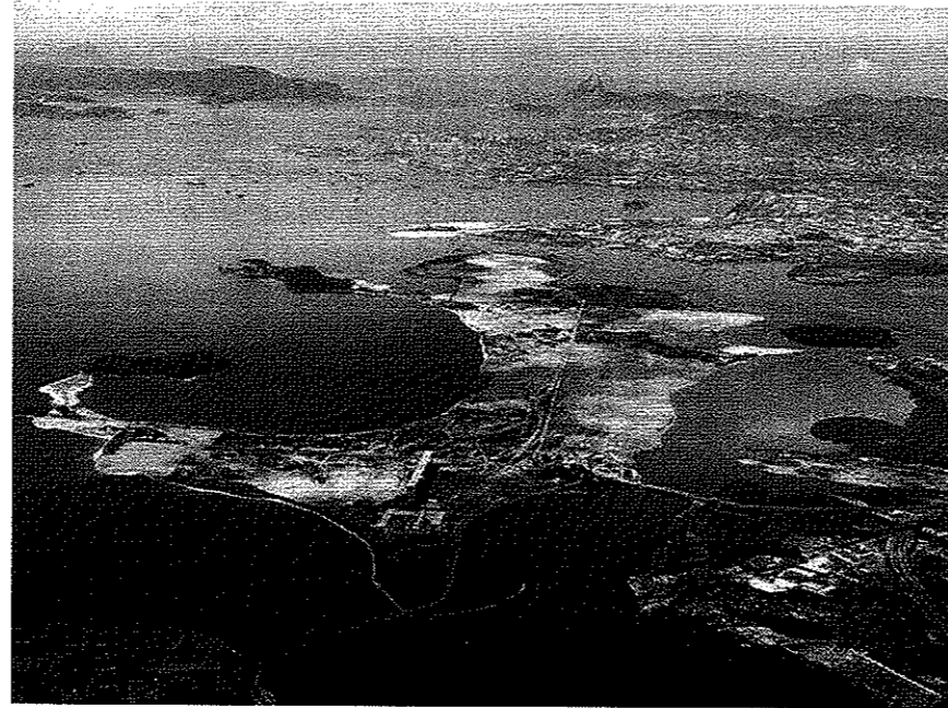
Figura 14.2. Obras de aterro hidráulico para a construção do campus universitário
