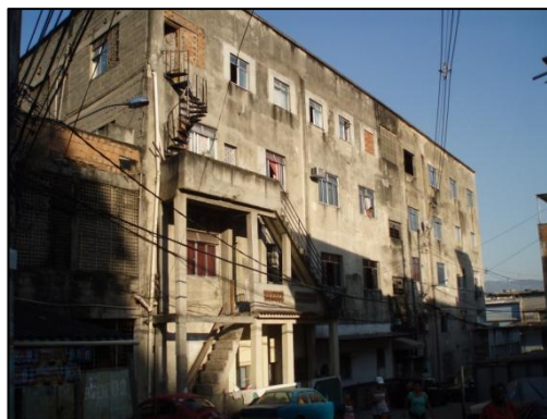
Photo 27 : Immeuble situé à l'entrée du terrain.
