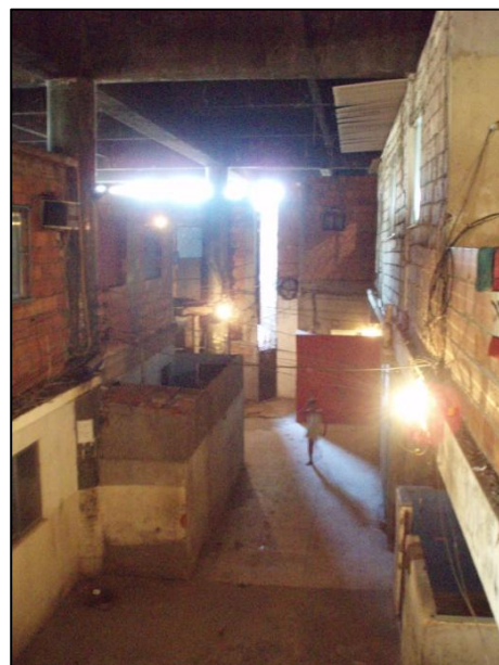
Photo 39 : Logements situés au premier étage de l'entrepôt qui donne sur l'Avenida Brasil.
