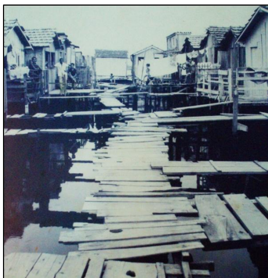
Photo 1 – Les ponts construits par les habitants pour accéder aux logements sur les palafittes (1969).
