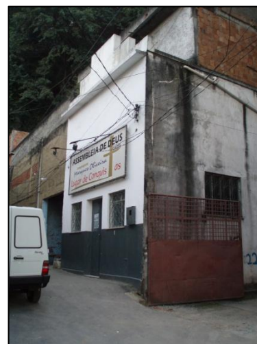
Photo 36 : L'église évangéliste à l'intérieur du « Condominio Barra Vela ».
