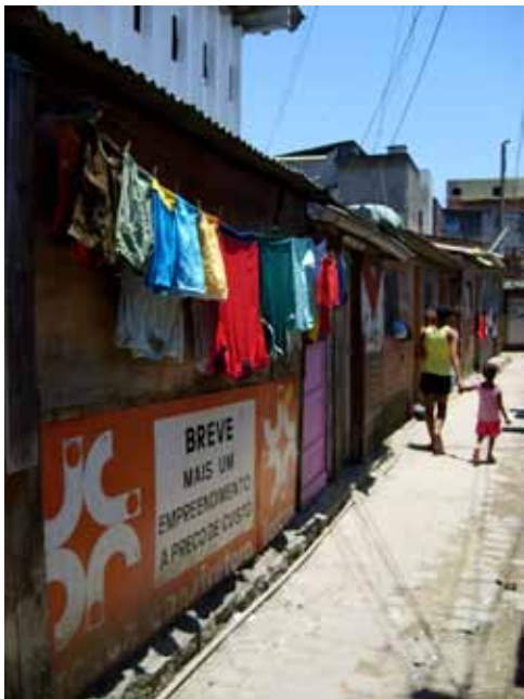
Casa na favela Embratel, em Manguinhos, construída com sobras de madeira e tapumes de lançamentos imobiliários. Foto: Leticia de Luna Freire, 2009.
