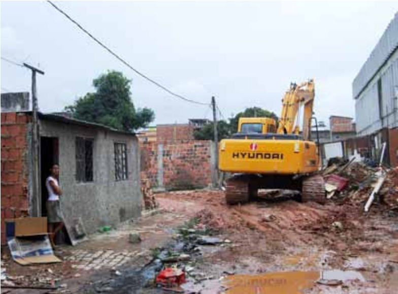
Moradora observa os trabalhos de demolição das casas na favela Embratel, em Manguinhos. Foto: Leticia de Luna Freire, 2008.
