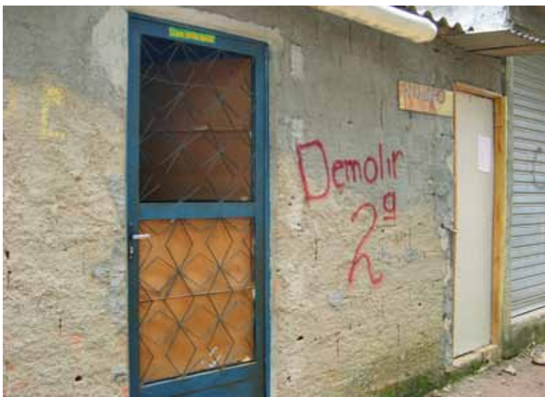
Demolição marcada: a agenda dos tratores nas fachadas da favela Embratel. Foto: Leticia de Luna Freire, 2008.
