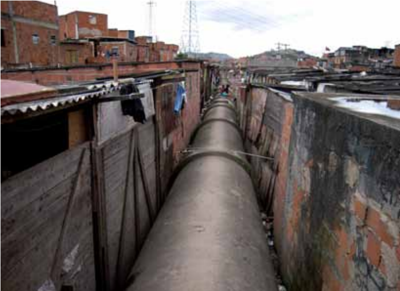
Uma adutora de esgoto atravessa Manguinhos, entre casas sem saneamento básico. Foto: Letícia de Luna Freire, 2009.
